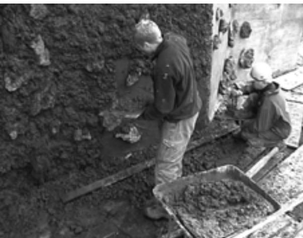
Völun er aðferð við veggjahúðun sem er háð því að notaður sé svokallaður seinkari í völnarlímið (múrblönduna) og yfirborðið síðan þvegið til þess að hreinsa óharðnaða sementsefju af yfirborði steinkurlans sem notað er. (Ljósmynd: Flosi Ólafsson, Línuhönnun.)
