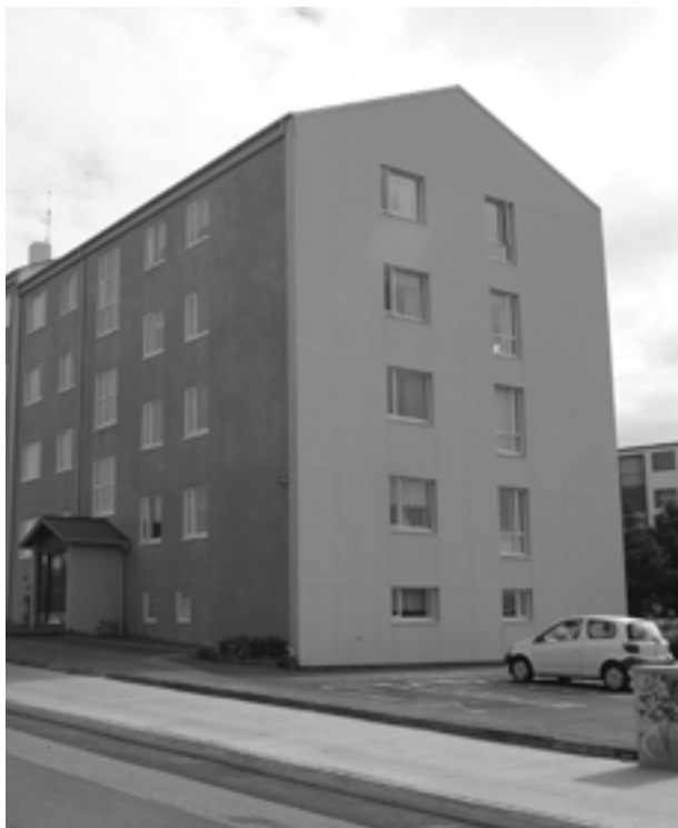
Viða hefur verið gripið til þess að klæða hús með svonefndum Steni-plötum. Endi blokkar við Hjarðarhaga í Reykjavík er þannig frágenginn en blokkin að öðru leyti steinuð.
