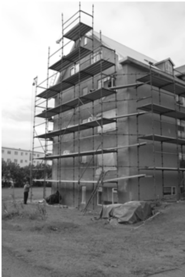
Unnið að endursteiningu fjölbýlishúss í Vesturbæ Reykjavíkur. Vinnupallar og allt efni er til reiðu. Jöfnunarlag er þegar komið á húsvegginn.
