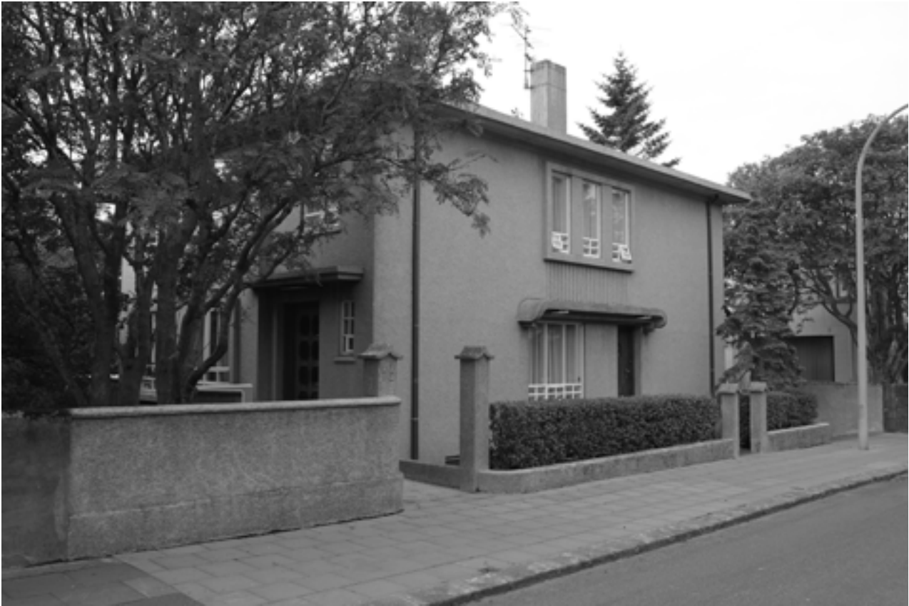
Steiningin á þessum húsum, við Laufásveg (að ofan) og við Eskihlíð (bls. 9), er órjúfanlegur hluti heildarinnar og gerir byggingarnar eftirtektarverðar.
