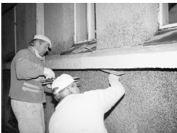
Frá upphafi steiningar og fram undir 1960 var þessi húðun útveggja mjög vinsæl. Hér er unnið við steiningu á síðari hluta 20. aldarinnar. (Ljósmynd: Línuhönnun.)
