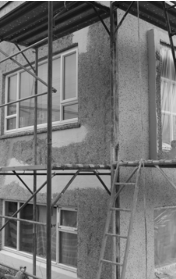
Unnið að endursteyningu húss við Engihlíð í Reykjavík.
