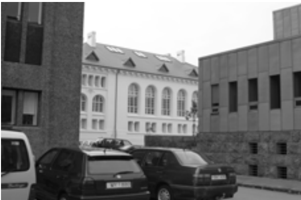
Varðveisla og nýting húsa og annarra mannvirkja er mikilvægur liður í lifandi menningarstarfi og felur um leið í sér varðveislu og nýtingu sjónmenntaarfs landsmanna.
