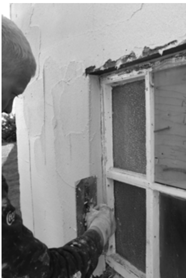
Unnið við að hræra steinlím (efri mynd) og við að bera steinlím á kverk við glugga.
