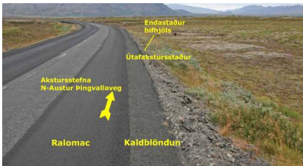
Mynd 1. Horft N-Austur Þingvallaveg. Viðgerð stóð yfir á veginum. Akreinskil og vegbrún voru óljós.
