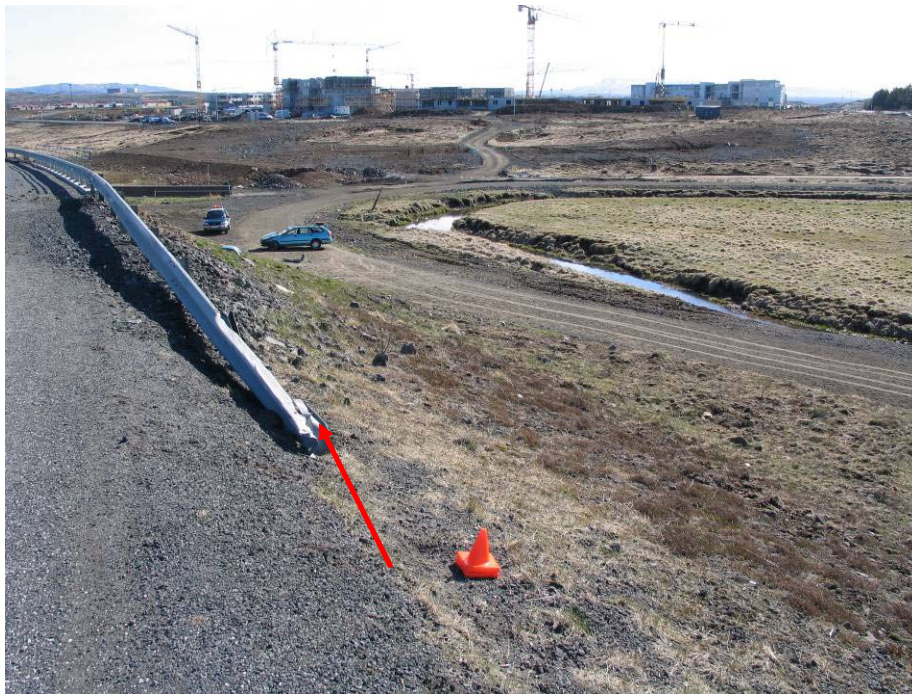
Vegrið beygt niður í jörð. Rauða örin vísar á leið ökutækisins upp vegriðið
