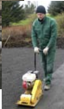
Snjólfur Eiríksson skrudgarðyrkjunemi að þjappa jarðveg undir hellulögn.
