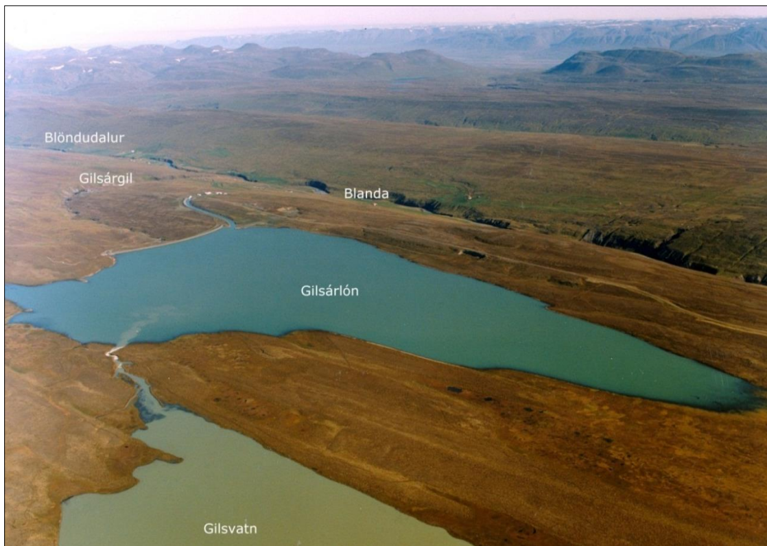
Mynd 7 Gilsárlón, inntakslón Blöndustöðvar, Blanda, Blöndudalur, Gilsárgil og Gilsvatn í forgrunni
