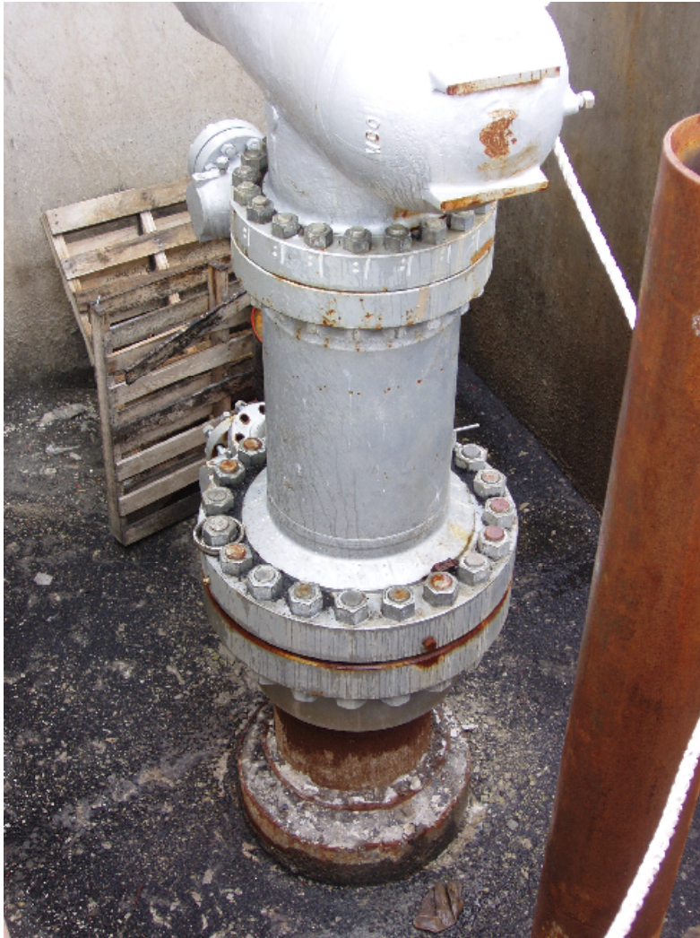
Mynd 6: Hér sést þensluslíf á holu REY H017. Að neðan er soðið við 18 5/8” öryggisfóðringuna, endinn á 13 3/8” er laus inní, en pakk á milli.
