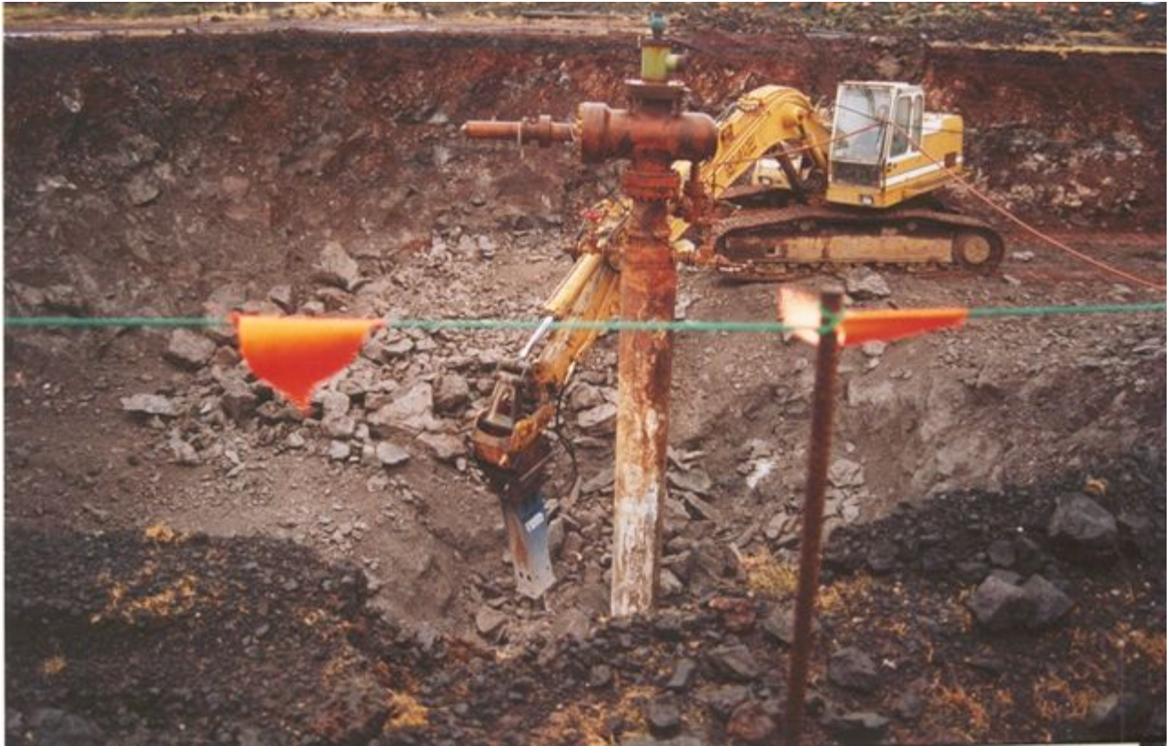
Mynd 7: Hér er verið að fleyga klöpp við holu REY H010.
