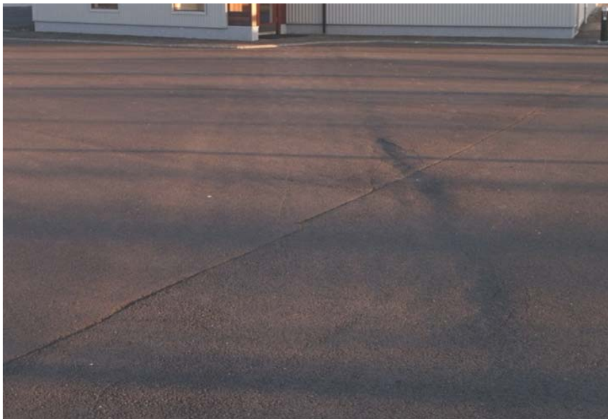
Mynd 30. Frostskegmdir í malbiki. Það er afar mikilvægt að allt efni undir steypu og malbiki sé „frostfrítt“ efni, þ.e. mól og sandur. Mynd: Jóhann Þórsson.
