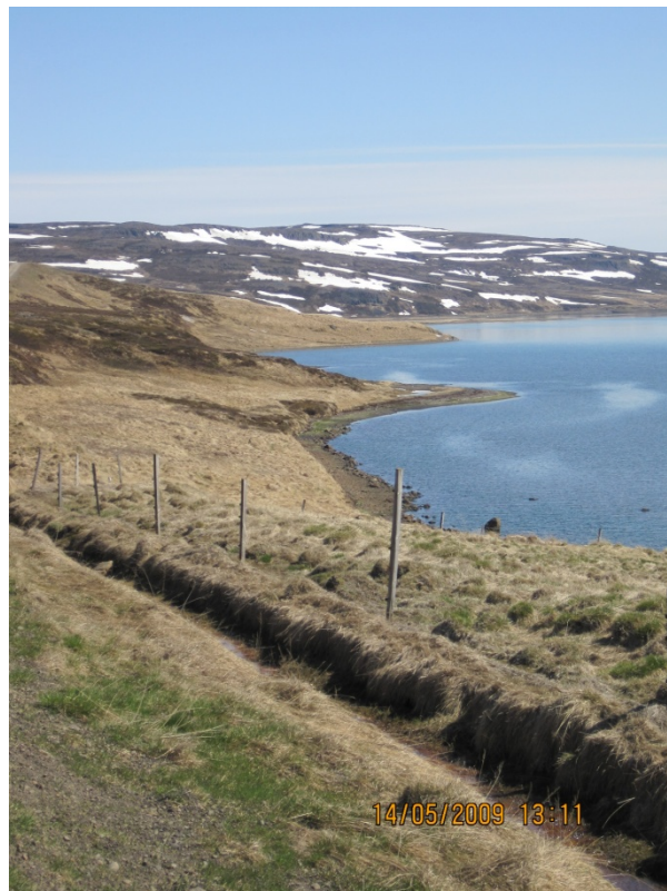
Mynd 4: Hér sér yfir tvo voga, sem vegurinn fer yfir milli stöðva 660 og 1020 annars vegar og hins vegar 1360 og 1660
