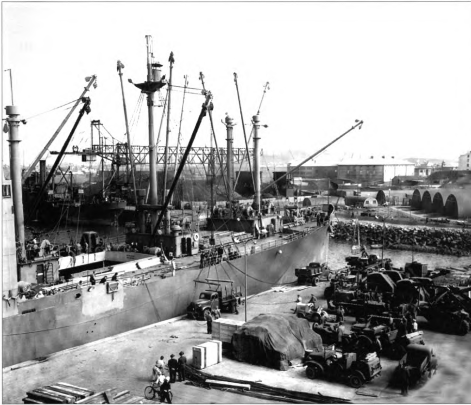
Reykjavíkurhöfn 6. ágúst 1941. Mikið mæddi á kolakrananum í Reykjavíkurhöfn. Starfaði hann sleitulaust við upp- og útskipun á kolum og koxi jafnt fyrir landann sem her og flota. Horft er til austurs af þaki Hafnarhússins. Ofan við stefni bandaríska herflutningaskipsins Almaac sér til Sænska frystihússins þar sem nú stendur hús Seðlabankans, en milli þess og kolakranans er kolaportíð sem geymdi kolabirgðir landsmanna. Braggarnir á hægri hönd eru vöruskemmur Breta. Bandaríkjaher fyllti síðar upp í hverkina, stækkaði hafnarbakkann og reisti stóra vöruskemmu á svæðinu er náði upp að Tryggvagötu. (NARC 75356-AC)
