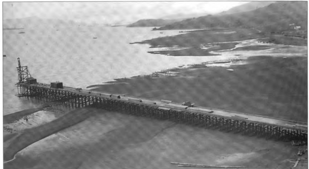
Oliúbryggjan í smíðum í júní 1942. Bryggjan var 370 m. löng og náði haus hennar fram á brún marbakkans undan Þyrilsklifi. Tréstaugar, sem reknir voru niður í sjávarbotninn, báru trégólf með 12 tonna burðargetu auk olíu- og vatnsleiðslna. Fjær sér til flötbryggjunnar á Miðsandi. (NARC 80-G-319865)
