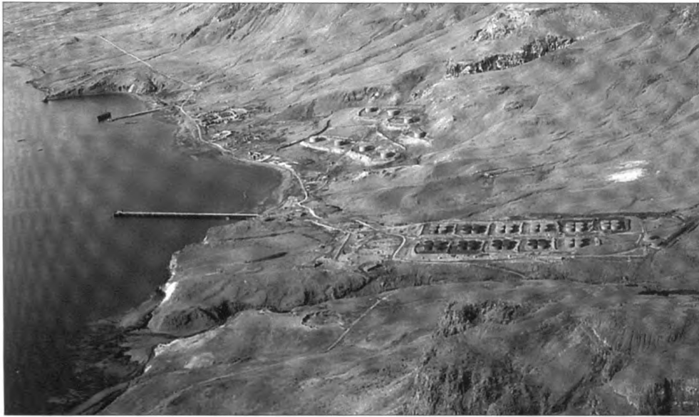
Mannvirki á Söndum fullgerð 23. september 1943. Fremst gnæfir kollur Þyrils yfir Bláskeggssá sem fellur í gljúfri fram með Þyrilsklifi. Oliugeymar standa á Klifmel og bensingeymar í hlíðinni ofan við Flatann og Alagabrekku og liggja lagnir frá þeim fram á bryggjuna. Skálahverfi og skipaviðgerðarstöð standa í tünnum bæjanna að Littla-sandi og Miðsandi og litlu vestar er flotbryggja innan við Gorvík. Olúbryggja NATO reis á þeim slóðum ásamt skálahverfi og stórum niðurgröfnum oliugeymum þar ofan við á sjötta áratugnum. (NARC 80-G-336957)
