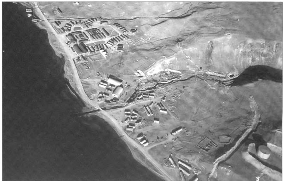
Skálahverfi olíu- og skipaviðgerðarstöðvarinnar á Söndum 4. október 1943. Miðsandsá, í gljúfri fyrir miðri mynd, skipti löndum með Miðsandi, að vestan, og Littasandi, að austan. Skálahverfi bygginga- verktakanna reis á túninu að Littasandi. Er bensingeymar höfðu verið reistir í brekkunni ofan við túnið voru íbúðarskálarnir færðir í nýtt hverfi sem reist var yfir starfsmenn stöðvarinnar í landi Miðsands utan árinna. Vestast er flotbryggja sem stóð lítið eitt austan við núverandi olíubryggju NATO. Þá er nýja skálahverfið, sem enn þá stendur að hluta, og sjást bæjarhúsin að Miðsandi í austurjadhri hverfisins. Litlu innar og vestan árinna eru geymslur og verkstæði til skipaviðgerða og gamla skálahverfið með vöruhúsum og verkstæðum austan árinna. Skurðurinn vestan við bensingeymana átti að beina hugsanlegu bensinflóði til sjávar. Vestan hans sjást tóftir Littasandsbæjarins sem Stefán Eyjólfsson bóndi hafði rífið og flutt á brott er hann hraktist af jörðinni. Skotgrafir liggja í krákustigum í holtinu ofan við nýja hverfið. (NARC 80-G-212365)
