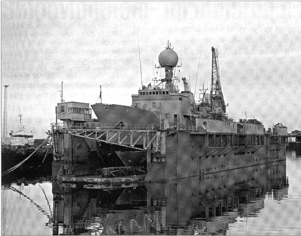
Flotkví sömu gerðar og A.F.D. XVII í Hafnarfirði 1997. Kvín er í raun þrammi með reisu með báðum hliðum sem hýsir vélbúnað hennar. Kvínni er sókkt og skipi hleypt inn yfir stokka á þilfari hennar og lyft úr sjó með því að dælt er úr tönkum kvíarinnar. Flotkvíin í Hvalfirði lyfti 28 skipum til viðgerðar á fyrra helmingi ársins 1943. (Höf.)
