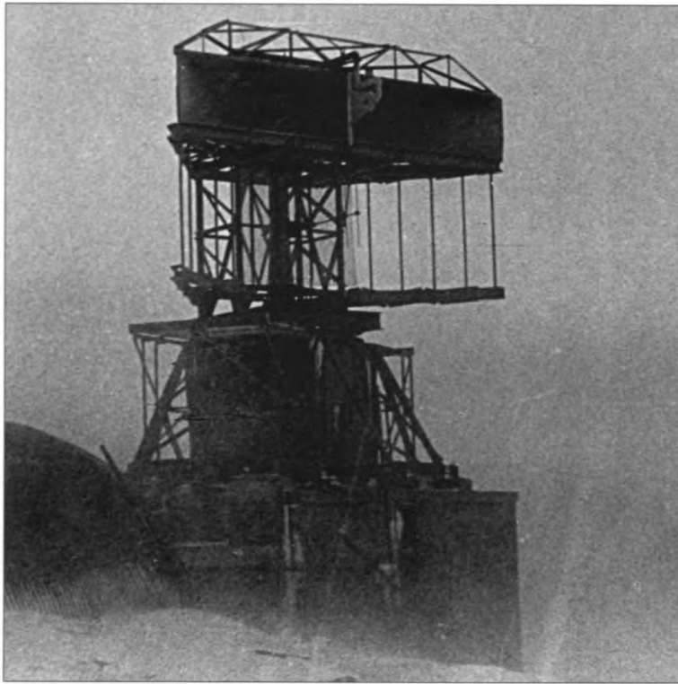
Nýja ratsjain á Darra var af gerðinni 277S sem var af nýrri kynslóð, mun öflugri og fyrirrennari nútíma siglingaratsjár. Loftnetið var tvöfalt, efri hlutinn með lokuðum spegli fyrir leitargeislann og neðri hlutinn með opnum spegli fyrir geisla svarratsjárinnar sem greindi endurvarp frá vinveittum skipum og hringsnerist ofan á ratsjárhúsinu þar sem stjórndur hennar rýndu í skjáina. (Historical Radar Archive)
