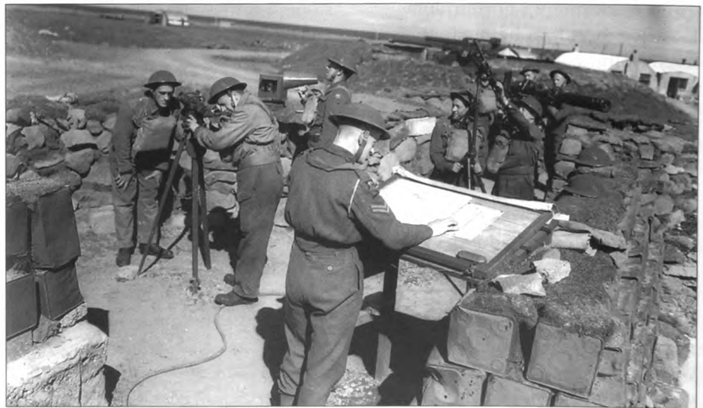
Sjónaukar og miðunartæki tengd reiknivél mældu hæð og fjarlægð skotmarksins og gáfu til kynna hraða þess og stefnu. Byssuliðarnir fengu fyrirmæli um í hvaða átt byssunni skyldi beint svo að kúlan flygi í veg fyrir flugvélinu líkt og þegar veiðimaður skýtur fugl á flugi. Sprengikúlurnar voru búnar kveikibúnaði sem stjórnaðist af klukku og var flugtimi kúlunnar stilltur sjálfvirkir samkvæmt boðum frá miðunartækjunum. Staflar af 25 lítra bensínbrúsum sem fylltir hafa verið sandi mynda skjól gegn sprengibrotum umhverfis byssustæðin og Bren-vélbyssa er til taks til varnar gegn steypiárás á byssustæðið. Camp Brighton 25. júlí 1942. (NARA 111-SC-146917)
