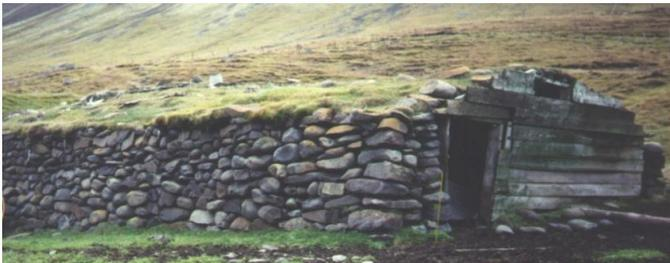
Der Schafstall in Skatastaðir im Tal Austurdalur ist doppelt gemauert und besteht aus Steinen und Grassoden. Größtenteils sind die Wände aus Steinen aufgebaut, doch die Methode beruht darauf,
