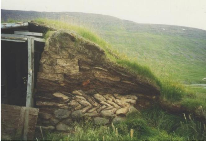
An der Giebelwand des Schafstalls in Hof im Tal Hjaltadalur sind Pferchziegel zu sehen, die oben flach ausgelegt und unten schräg angeordnet wurden. Der unterste Teil der Wand besteht aus Steinen, gedeckt ist sie mit Wiesenplatten.
