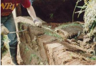
oder dessen Rücken weist nach außen, die dünnere nach innen. Der gesamte Verschnitt kommt zusammen mit Abbruchsoden oder anderem Material, das zur Auffüllung verwendet wird, in die Wand und wird festgestampft. Es ist wichtig, das
