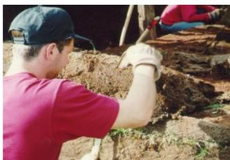
Sobald der Flickenziegel gut eingepasst ist, wird er zurechtgestutzt. Am Nacken wird ein Stück abgeschnitten, wodurch der Sattel für den Grasstreifen entsteht, der die Bindung des Verbandes sichert. Die dickere Längsseite des Grasstreifens
