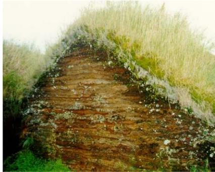
**Grasplatten** und **Grasstreifen** wurden längs und quer zwischen die Lagen aus Grasziegeln geschichtet, um einen Verband herzustellen. Sie erfüllten sozusagen die Funktion eines „Bindemittels“, sofern die Wand nicht ganz aus ihnen gebaut wurde, wie es im Skagafjörður durchaus üblich war.
