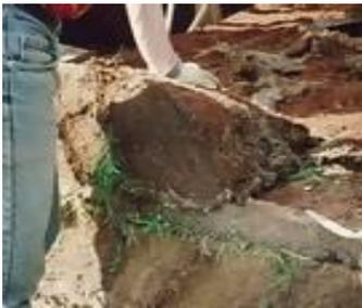
Bei der Anordnung des Flickenziegels in der Wand weist der Nacken nach außen und der Schwanz nach innen. Der Ziegel wird auf die Seite gewälzt, sodass das Gras an einer seiner beiden Längsseiten am nächsten Ziegel anliegt und erstickt.
