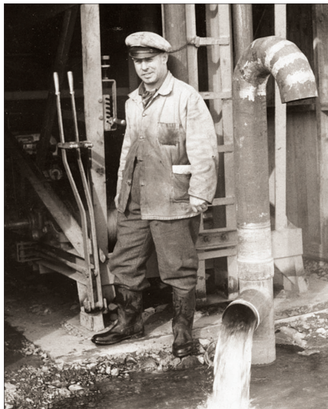
Jón við dælu sem hann útbjó fyrir heita vatns borholu í Áshildarholtstjörn á 6. áratug 20. aldar (HSK).
