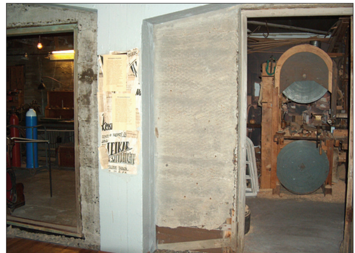
Á myndinni er horft inn í járnsmíðaverkstæðið, til vinstri, og trésmíðaverkstæðið, til hægri, þar sem þau standa nú hlið við hlið inni í Minjahúsinu. Á trésmíðaverkstæðinu blasir við bandsögin sem Ingólfur Nikodemusson smíðaði 1948 og notaði alla tíð. Veggir verkstæðisins eru forskalaðir, þ.e. múrað er á vírnet sem strengt er á trégrind. Reiðingur, torf, er til einangrunar (BSk).
