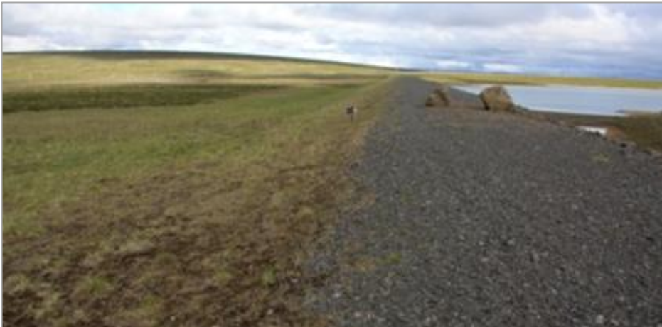
Mynd 3 (a og b). Fannlækjarstífla við Smalatjörn. Séð ofan á stíflu og lónmegin (efri mynd) og loftmegin (neðri mynd).
