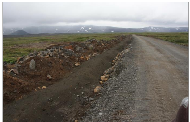
Lagnaleið í vegkanti, - gróft efni sem ekki nýttist við vegfláa verður flutt burt.
