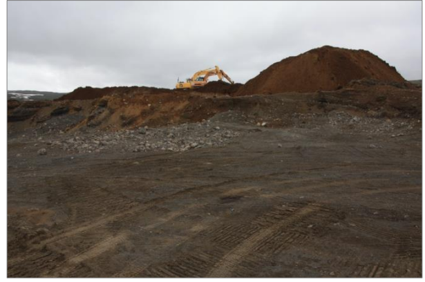
Náma RHN-5. Jarðvegi ýtt til hliðar til síðari nota. Athuga að nýta mulning ofan á efsta lag (sjá Mynd 4).
