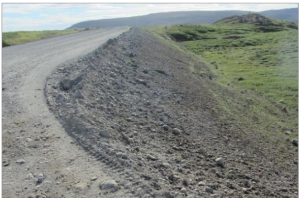
Uppbyggður vegur í hrauninu. Gæta þarf að því að móta vegfláa í takt við form, liti og gróður í nágrenninu. - Sjá Mynd 2 og Mynd 5.
