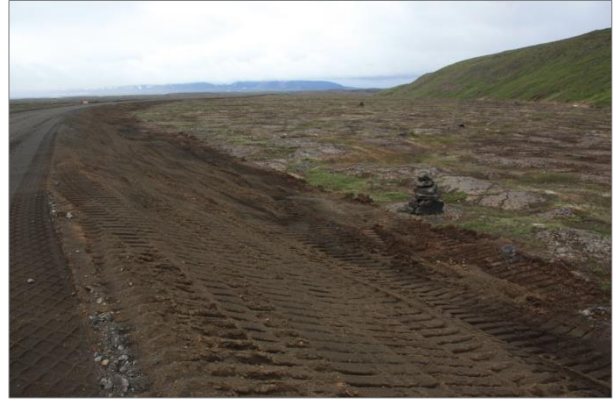
Frágangur vegar í Þeistareykjahrauni. Mælt er með að nýta gróft efni á yfirborðið hér og þar og sá í það.
