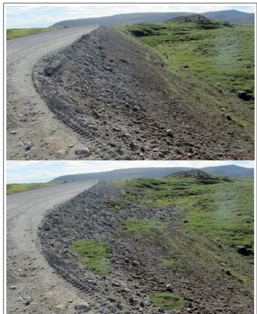
Mynd 2. Skissan sýnir hvernig aðlaga má vegkantinn betur að formi landsins í kring, en þess gætt að gróðurtorfur séu síðan lagðar ofan á vegkantinn ásamt mulningi að mótun lokinni.
