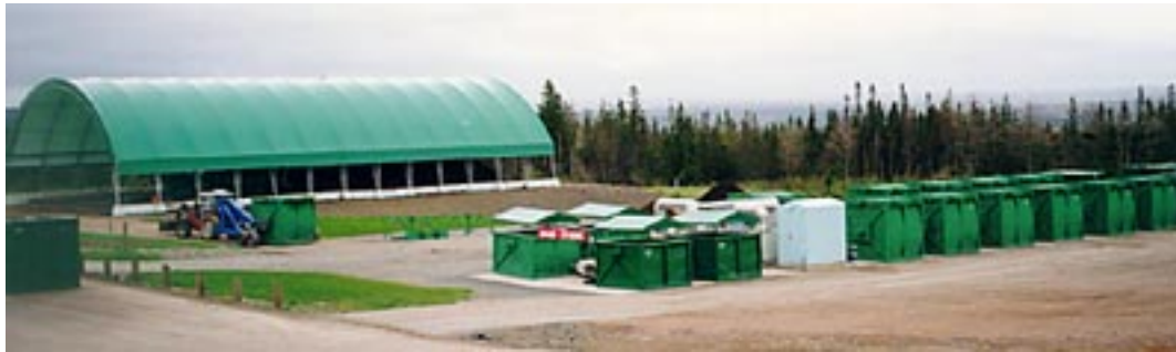
Mynd 2.1-10 Gámaaðferð frá Stinnes Enerco, System 25.1. Gámarnir sjást í forgrunni. Blásarar og stjórnþeki eru í ljósu kössunum sem sjást á myndinni. Gámarnir eru fluttir úr stað og hellt úr þeim með sérstöku tæki sem dráttarvél dregur (sjá mynd). Byggingin að baki er eftirmeðferðarstaður þar sem efnið er lagt í opna, óloftaða múga (úr bæklingi frá Stinnes Enerco).
