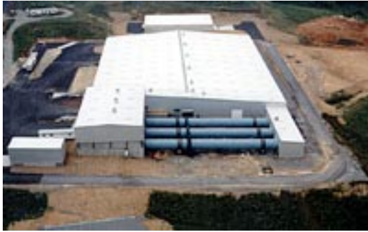
Mynd 2.1-14 Snúningstromluaðferð í Sevierville, TN. Þessi stöð hóf starfsemi 1992 og tekur við 225 tonnum af sorpi á dag og 112 tonnum af seyru. Framleiðandinn er Bedminster sem er í einni „sæng“ með Rondeco.
