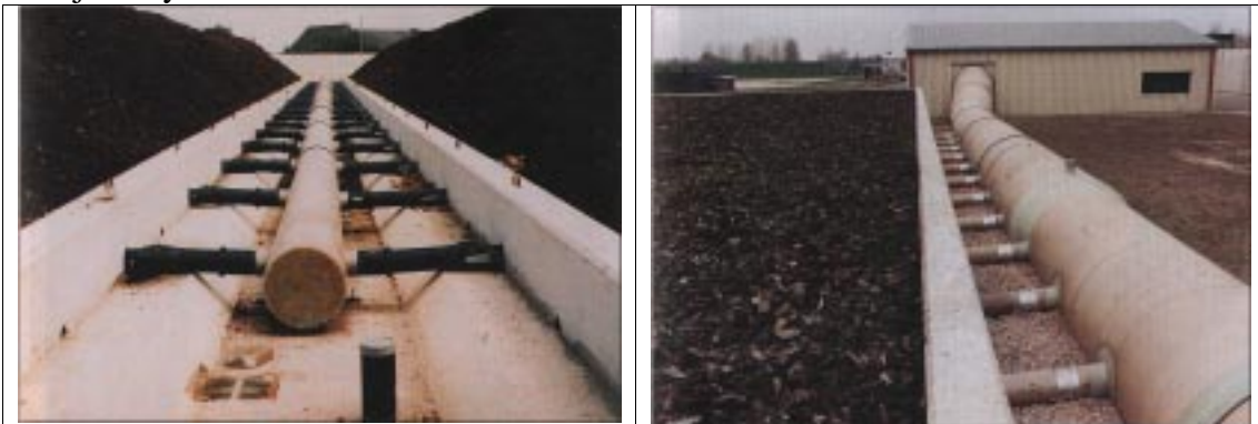
Mynd 2.1-18. Opnir kassar (s. „boxkompostering“) sem staðsettir eru utanhúss. Myndirnar eru frá Wilp-Achterhoek/Apeldoorn í Hollandi, úr „Biological Treatment of Domestic Waste in Closed Plants in Europa - Plant Visti Reports“, RVF Report 98:8)
