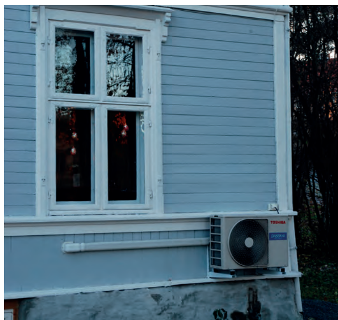
Luft-til-luft varmepumper krever lite inngrep i bygningen, men det kan være vanskelig å finne en diskret plassering.
