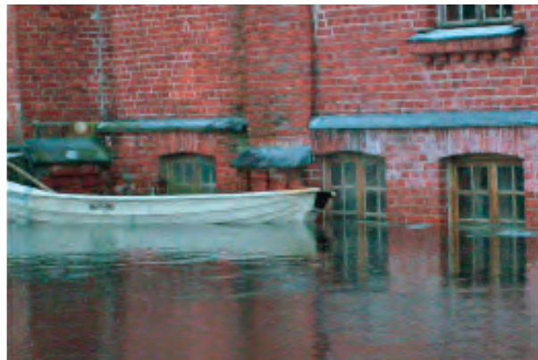
Oversvømt fabrikkbygning, Verla.
