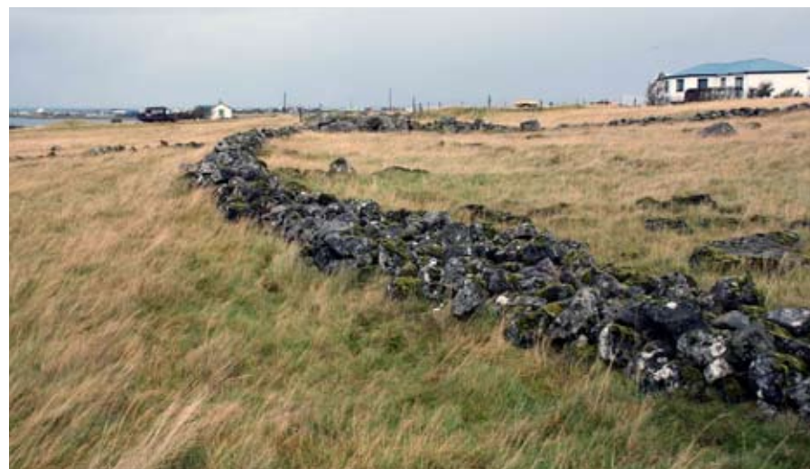
Mynd 4.2.10 Garðatúnveggur er misvel farinn
