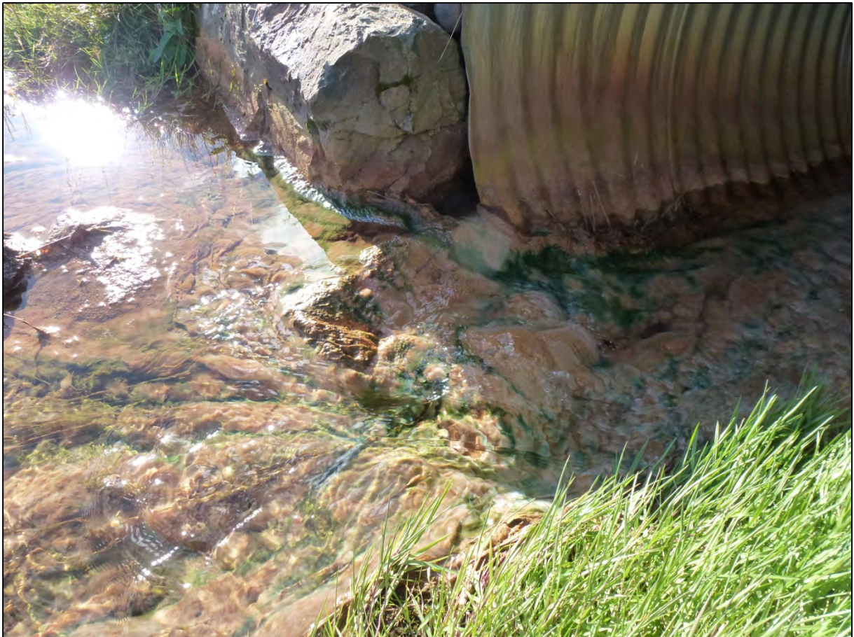
Mynd 15. Slýgróður er líflegur við athugunarstað LB-2 (V1 hjá HAUST) sem bendir til næringarefnaríks vatns.
