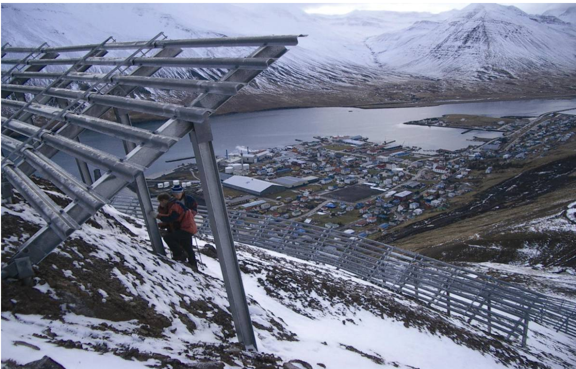
Mynd 3.3 Upptakastoðvirki ofan byggðarinnar í Siglufirði. Áætlað er að upptakastoðvirki í Kubbanum verði í sama formi og þau sem sjást á myndinni. Ljósmynd, Stefan Margreth.
