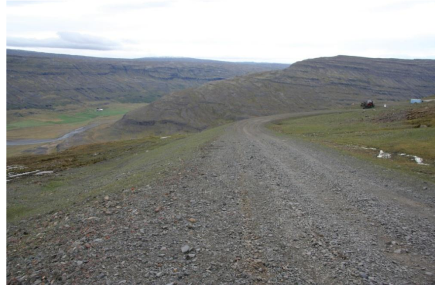
Mynd 16 – Aðgöng 2. Myndin er tekin í lok verktíma og sést hér frágangur að gangnamunna þegar verið er að leggja lokahönd á verkið.
