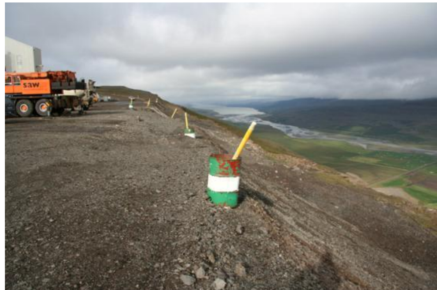
Mynd 13 – Aðgöng 1, fyllingar utan við gangnamunn þegar verkið var í gangi..
