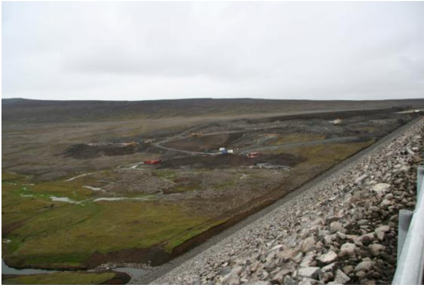
Mynd 17 – Aðgöng 4. Myndin er tekin ofan af Desjarárstíflu á framkvæmdartíma.
