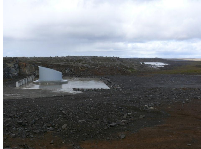
Mynd 22 – Svæðið á framkvæmdatíma, eftir að steypu og uppsetningurvinnu er lokið.
