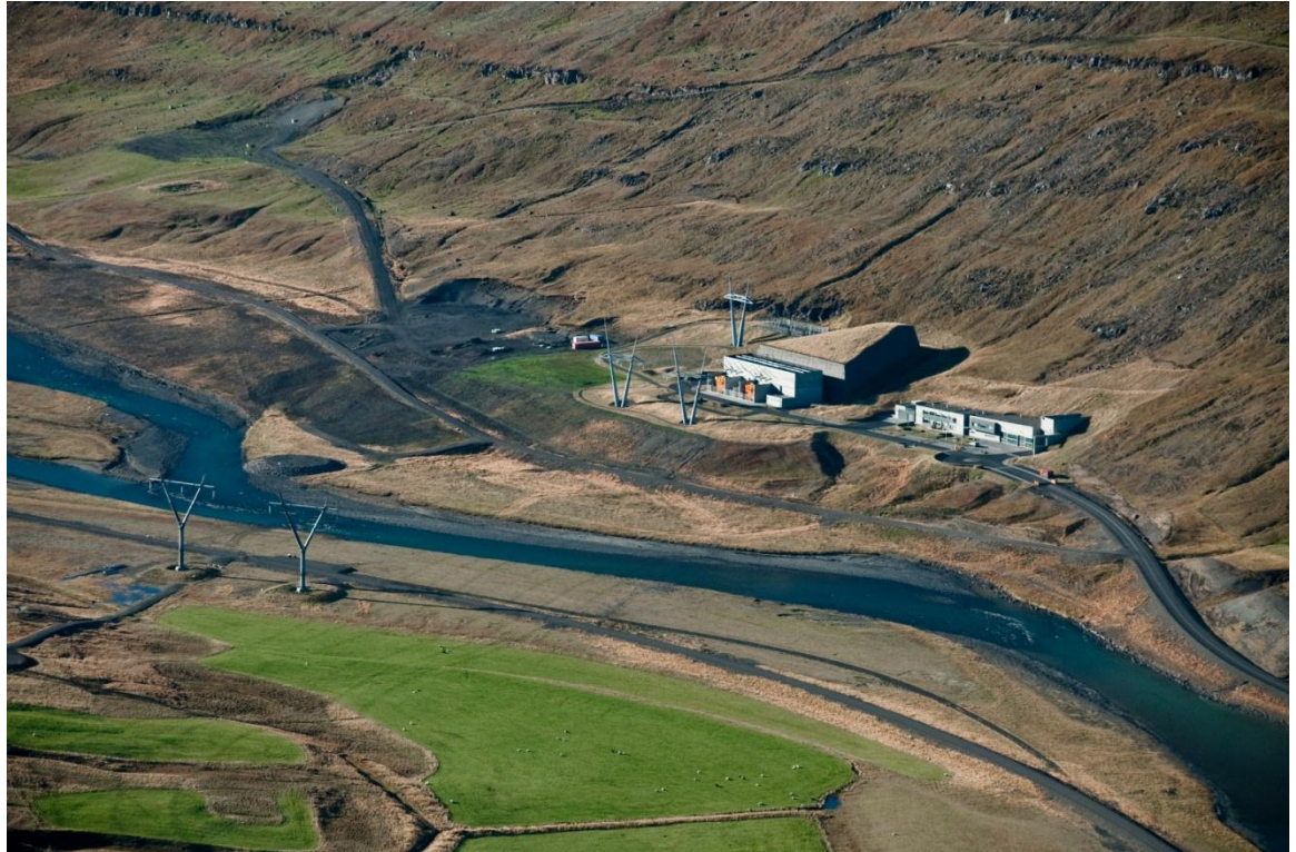
Mynd 8 - sýnir haugsvæði ofan við Stöðvarhlað, sem er svæði meðfram ánni vinstra megin á myndinni og tengist Stöðvarhlaðinu. Svæðið var mótað úr efni frá stöðvarhelli og rennislisgöngum.
