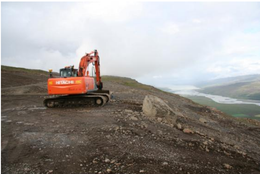
Mynd 14 – Aðgöng 1, mynd tekin þegar unnið var að frágangi. Fyllingin öll dregin til baka frá fjallsbrún og línur mýktar.
