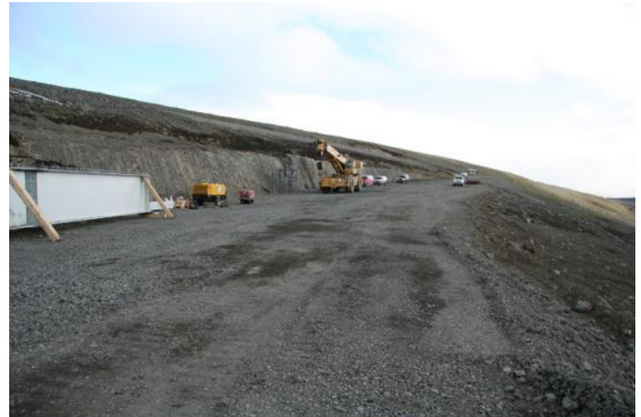
Mynd 33 – Bílastæði vestan brúar við Kárahnjúkastíflu á framkvæmdartíma.
