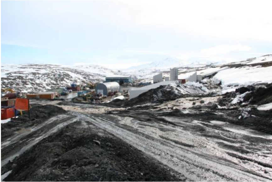
Mynd 15 –Tekin að vori við aðkomu að aðgöngum 2. Hér sést steypustöð, verkstæði og birgðageymslur á verktíma. Næsta mynd sýnir u.þ.b. sama svæði eftir lokafrágang svæðis.
