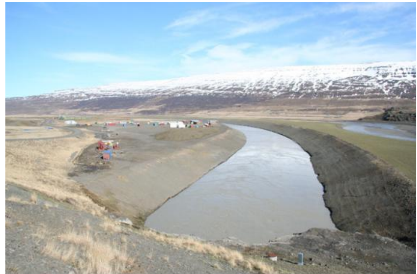
Mynd 40 – myndin er tekin á framkvæmdartíma ofan við frárennslisskurð. Eftir er að hreinsa til á Hvammseyri til vinstri á myndinni. Búið er að móta svæðið hægra megin við og sá í svæðið.
