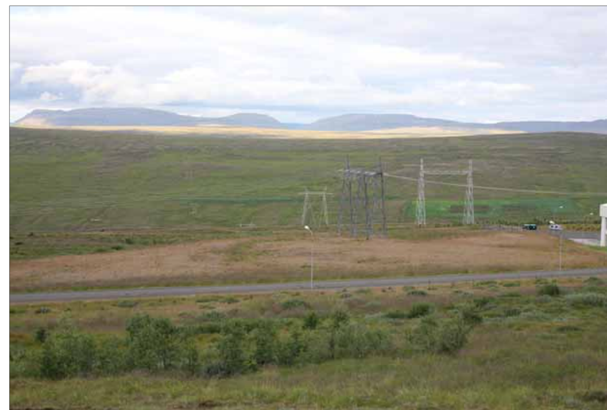
Mynd 39c Við Blöndustöð. Sýnt er hvernig hugsanlegt útlit línu verður eftir að sínkhúðuð stálmöstur hafa veðrast.
