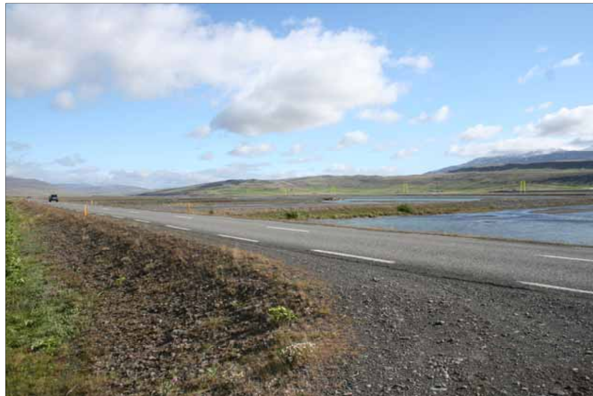
Mynd 48b Við Úlfsstaði. Mynd sýnir línu þar sem möstur og leiðarar eru sýnd með verulega áberandi lit. Fjarlægð er 1,2 km í mastur lengst til hægri, svo 1,4 km, 1,7 km og 2 km í næstu möstur.
