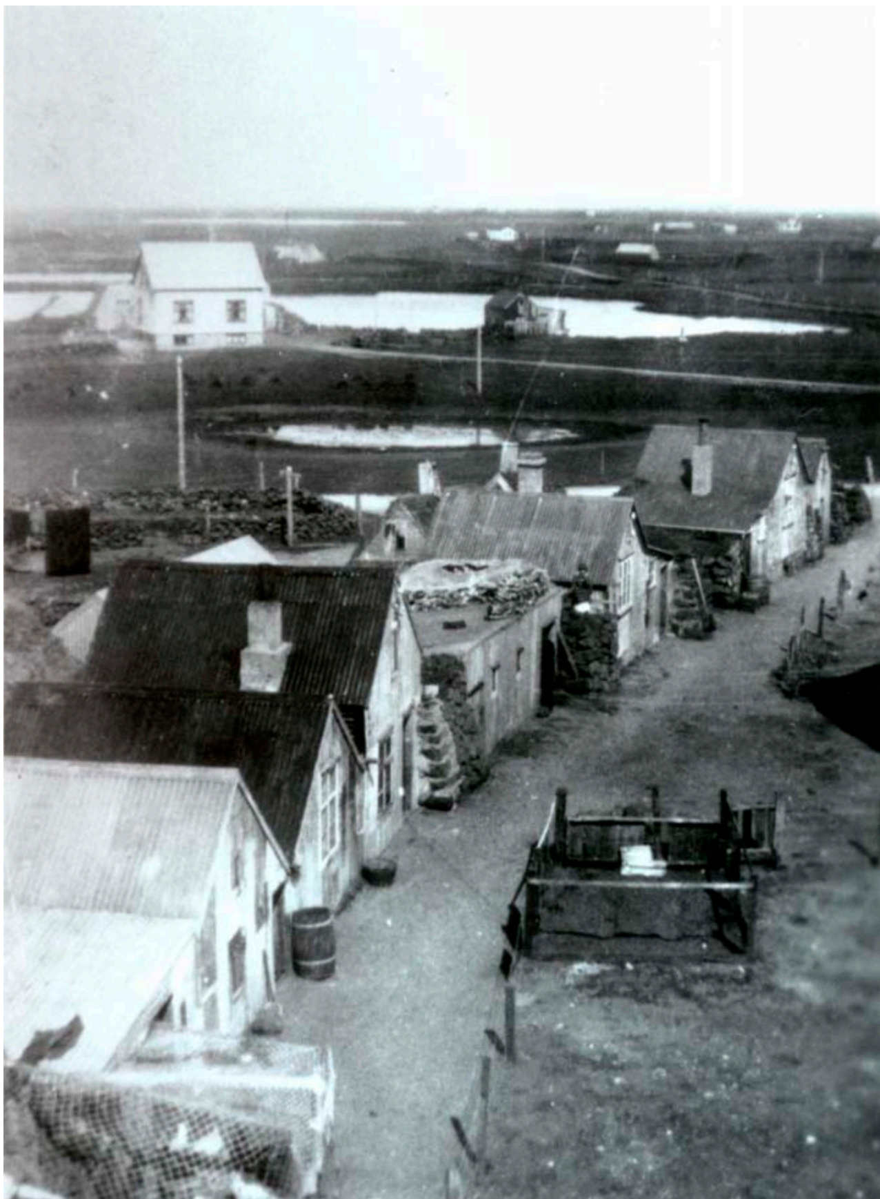
Beinateigshverfið vestan við Stokkseyrarhlaðið var einstök raðbygging torfhúsa sem snéru framhlið út að götu en við bakhlið þeirra voru hús sem snéru þvert á aðalhúsin. Húsin voru klædd bárujárnni og hliðarveggir steinhlaðnir. Þessi hús eru öll horfin nema ysta húsið í röðinni, Hausthús. Ljósá húsið ofarlega t.v. á myndinni er Ranakot byggt árið 1933. Ljós. óþekktur. Byggðasafn Árnesinga.
