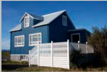
Sólvellir 10 Símonarhús Byggt 1919
