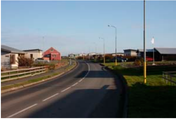
Við Hásteinsveg standa hús sem byggð eru eftir 1960. Þau eru ýmist með lágu einhalla þaki eða lágu risþaki og standa innarlega á afgirtum lóðum.
