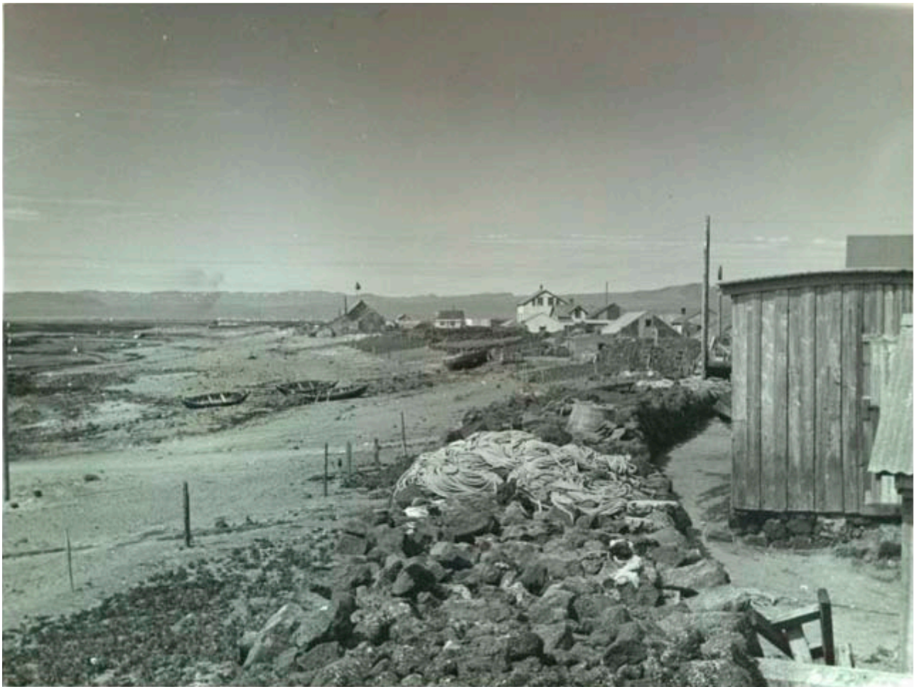
Stokkseyri fyrir stórbrunann árið 1926. Róðrabátar eru í fjörunni fyrir neðan Bátatún og kartöflugarðar neðanvert við sjóvarnargarðinn og beitningaskúrar innan hans. Ljósá húsið fyrir miðri mynd er Nýi-Kastali sem enn stendur og framan við það er húsið Beinategur sem hefur verið rifið. Ljós. óþekktur. HérÁrn.
