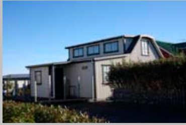
Sandgerði 3 Sólbakki Byggt 1899
