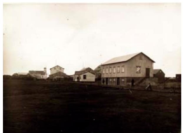
Stokkseyri á tímabilinu frá 1921, þegar Gimli t.h. var byggt, og fram til brunans 1926. Öll húsin á myndinni eru horfin árið 2010 nema Stokkseyrarkirkja og Gimli. Ljós. Haraldur Blöndal. Þjms.
