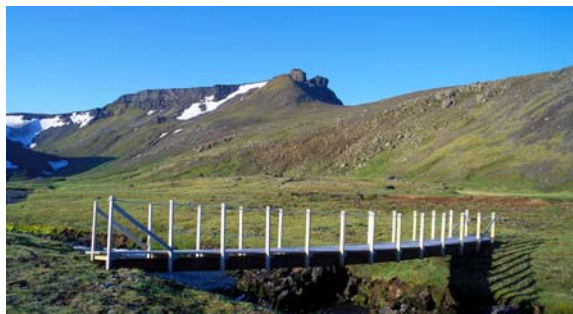
Mynd 6-3 Göngubrú yfir Móðulæk í Eysteinsdal.
