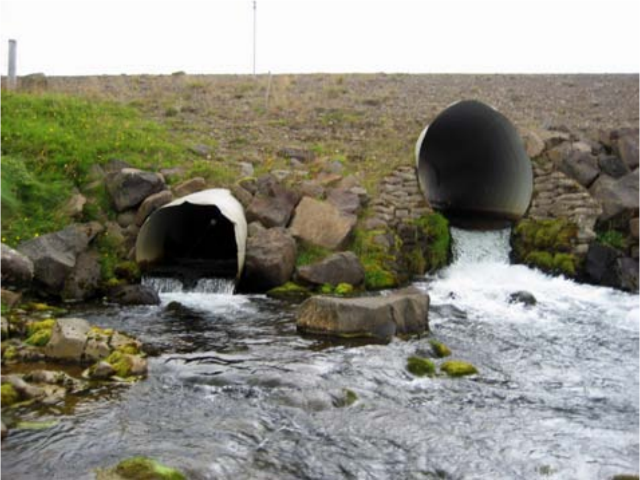
Mynd 27.1. Ræsi í Stafá. Neðra ræsið var sett í ána til að lagfæra aðgengi fiska upp ána. Ljósmynd, Auðunn Hálfðanarson.
