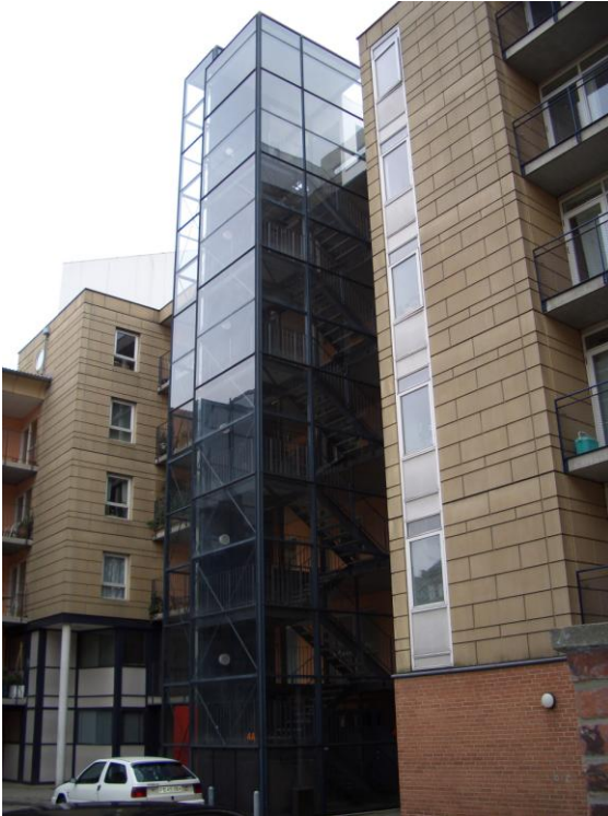
Utanpåliggande hisschakt av glas
