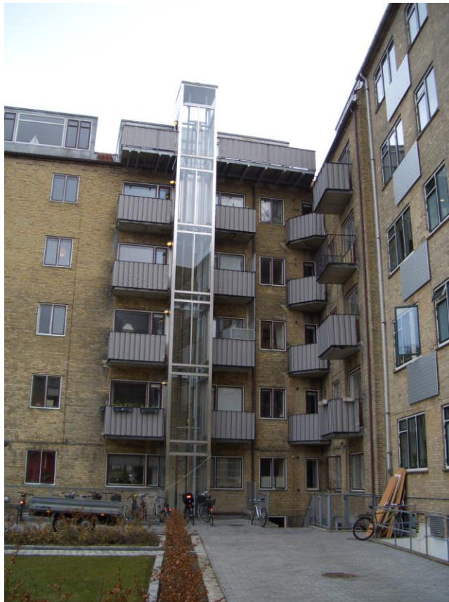
Utanpåliggande hisschakt med entré via balkong
