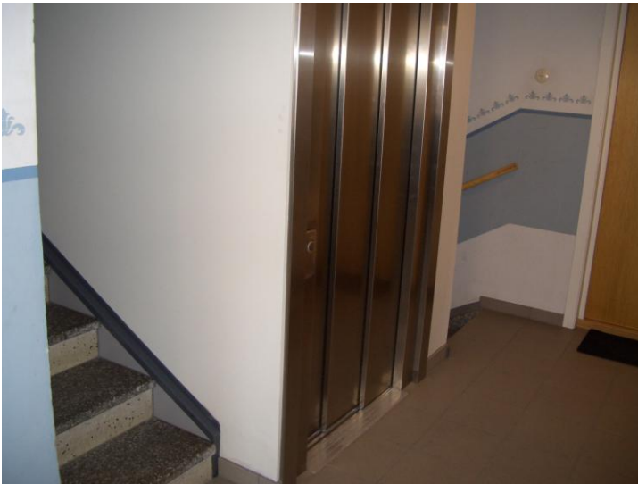
Typisk inbyggd hiss i en äldre fastighet
