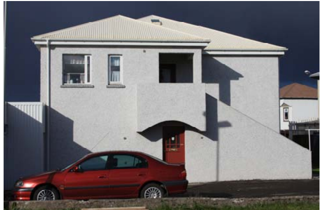
Suðurgata 62 B, hefur nýlega verið endursteynað.
