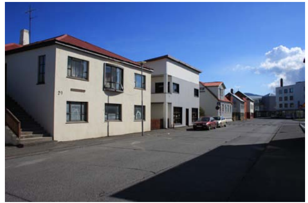
Á Neðri- Skaga eru húsin fjölbreytileg að gerð og byggingarefni og standa mörg hver frammi við götu og mynda þétta byggð.
