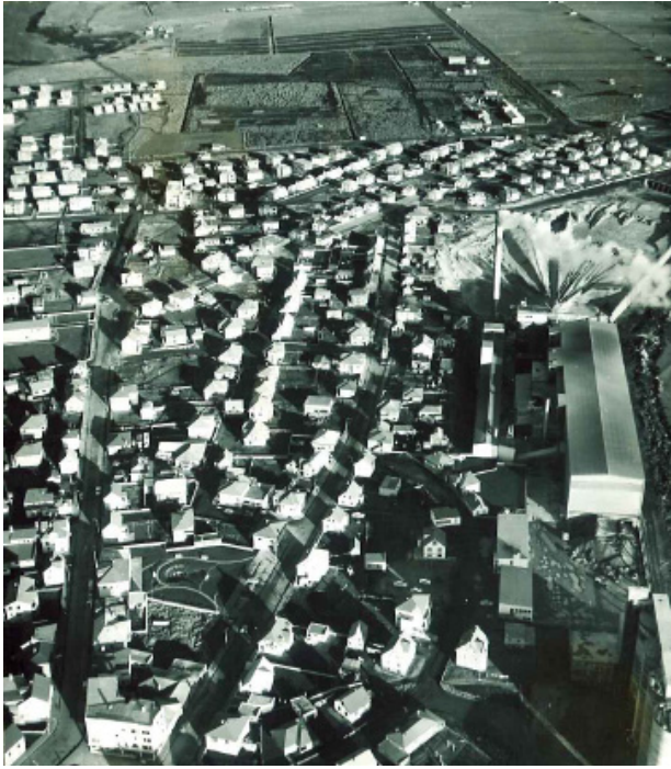
Sementsverksmiðjan lengst t.h. var byggð svo að segja upp að íbúðahúsum við Mánabraut og Suðurgötu og flest öll húsin sjávarmegin við þær götur voru síðar rifin eða flutt burtu. Ljós. Þorsteinn Jósefsson, um 1958. Skipulagsstofnun.
