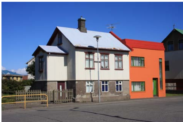
Akratorg. Skólabraut 35 og 35A. Varðveislugildi beggja húsa 2.
