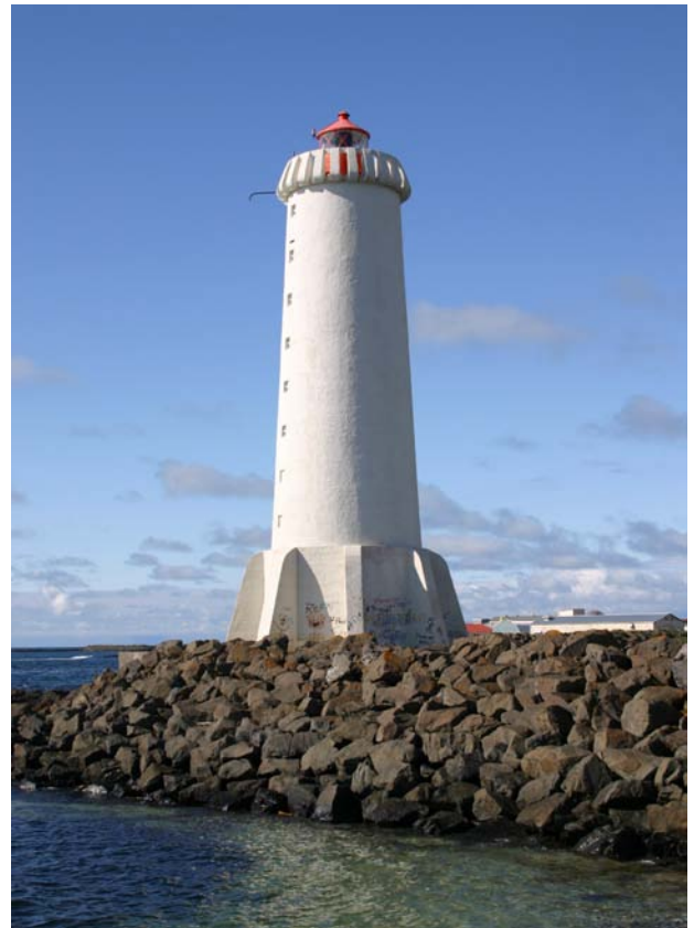
Akranesviti, byggður 1943-1944. Axel Sveinsson verkfræðingur.
