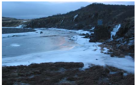
11. mynd. Vhm 128 í Norðurá. Grænt mælibúrið er hægra megin við ána. Flætt hefur inn í mælibúrið (flóð 1983) og náði flóðhæð í desember 2006 rétt neðan við mælibúr. Mynd: Vatnamælingar Orkustofnunar.
