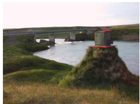
10. mynd. Vatnshæðarmælir 66 (brunn síriti) við Kljáfoss, Hvítá. Mynd: Vatnamælingar.
