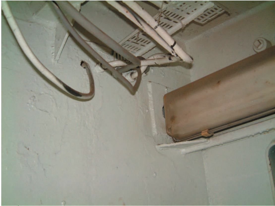
B3: Óþéttur losaralegur frágangur röra og kapla í vatnsþéttum þilum.
