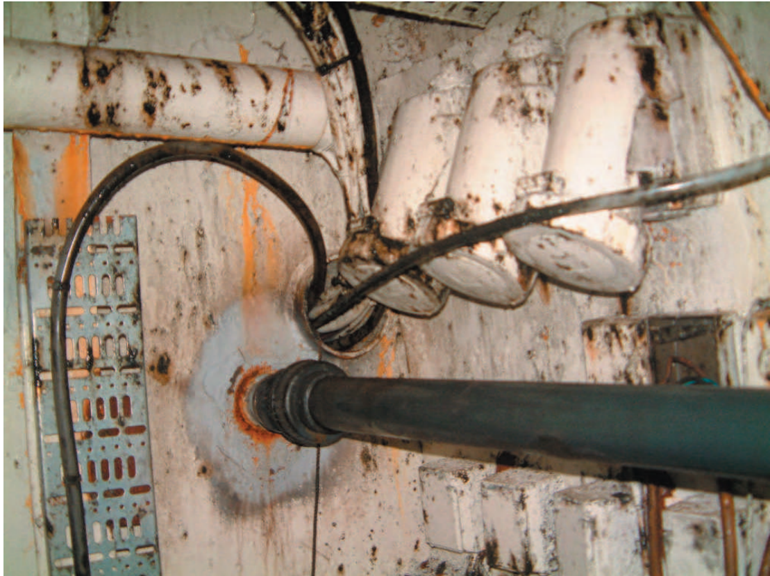
C6: Kaplar færðir gegnum op fyrir landkapal sem á að vera lokað og vatnsþétt.
