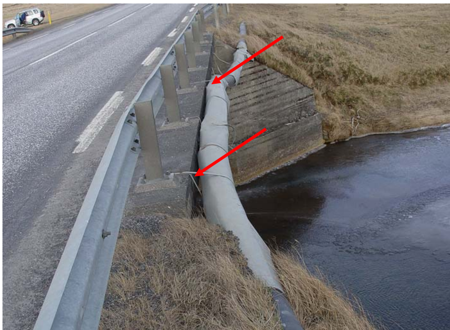
Mynd 1. Brúin yfir Gljúfurholtsá á Þjóðvegi nr. 1, Suðurlandsvegi. Heitavatsleiðslan hangir í girðum á brúnni norðanverðri.
