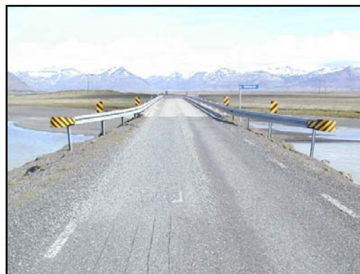
Mynd 7. Brú yfir Djúpa (Holtakil) á Mýrum, byggð 1970
