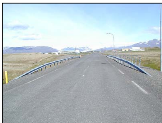
Mynd 3. Brú yfir Laxá í Nesjum, byggð 1995
