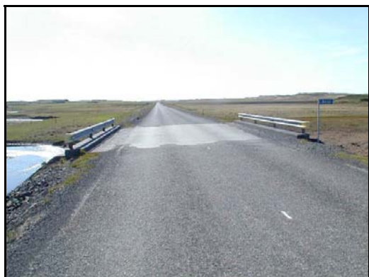
Mynd 2. Brú yfir Bergá, byggð 1974
