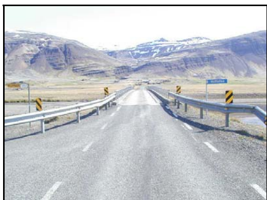
Mynd 4. Brú yfir Hoffellssá, byggð 1960
