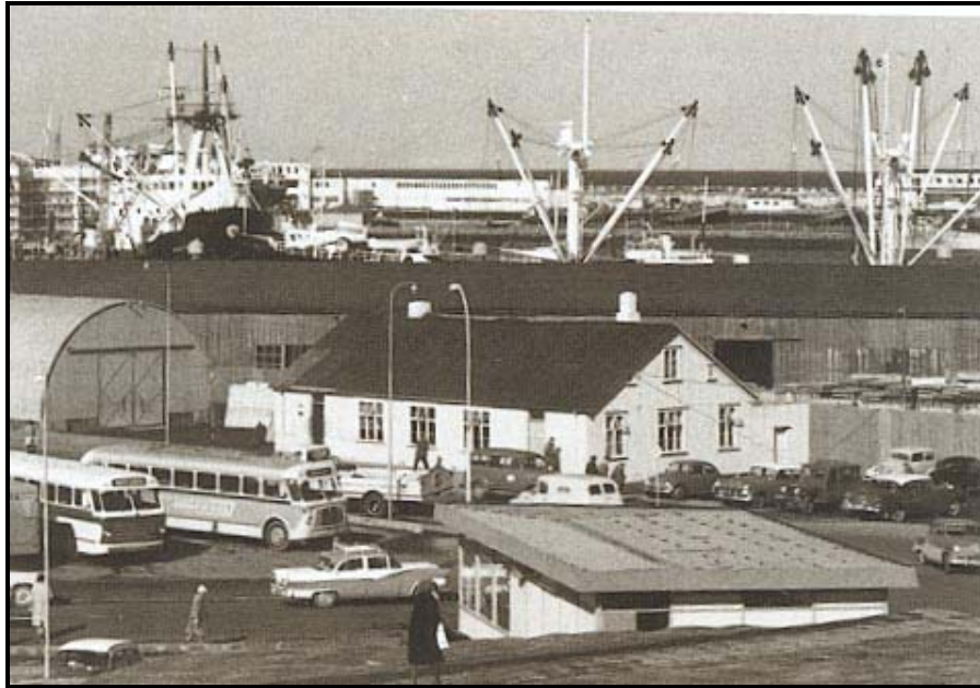
Mynd 23. Fyrir miðri mynd má sjá Verkamannaskýlið árið 1961. SS 144
