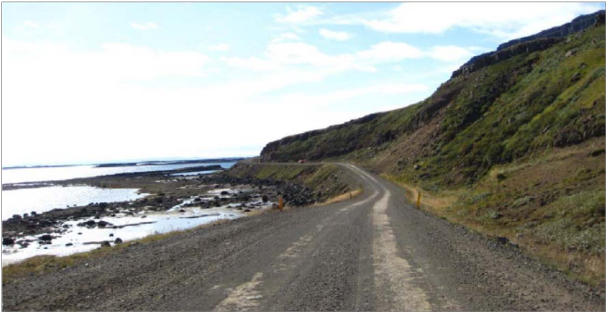
Mynd 6.10.22. Kirkjubólslífi á milli stöðva 5500-5600. Skorið verður af hamrinum auk þess sem fyllingar ná niður í fjöruna á um 90 m kafla (sjá mynd 6.10.23.).
