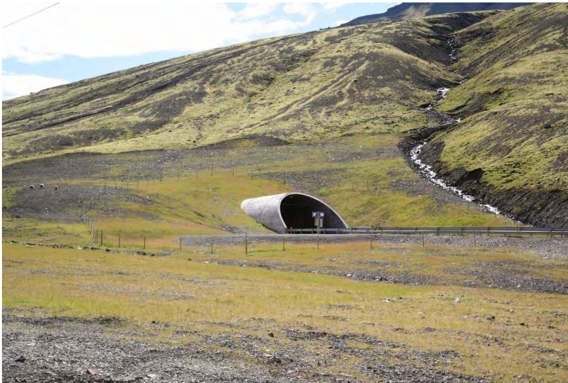
Mynd 15. Séð á hlið vegskálans í Almannaskarði. Myndin er spegluð svo munninn snúi í sömu átt og munni Dýrafjarðarganga. Munninn Dýrafjarðarmegin mun koma í svipaðri beygju út úr fjallinu. Mynd Ágúst Guðmundsson.
