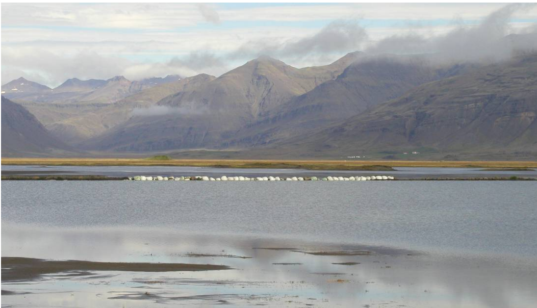
Mynd 19.1: Varnargarðar fyrir norðan Skógey. Gamlar heyrúllur notaðar til að hindra að vatn flæði inn á gróin svæði.
