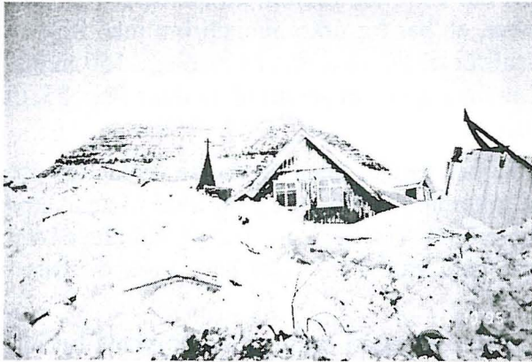
Mynd 4. Eftir Flateyrarflóðið. Ris að Unnarstíg 1 barst með flóðinu. Hjón og tvö börn voru í risinu og björguðust (SHH).
