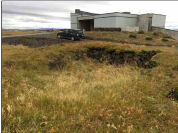
Beitarhús ÁR-246:013_01, horft til suðausturs.
