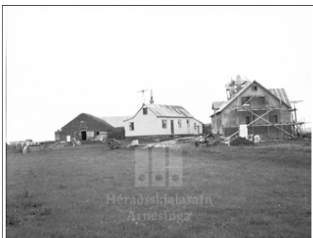
Álfsstaðir árið 1951, núverandi íbúðarhús er í byggingu.
