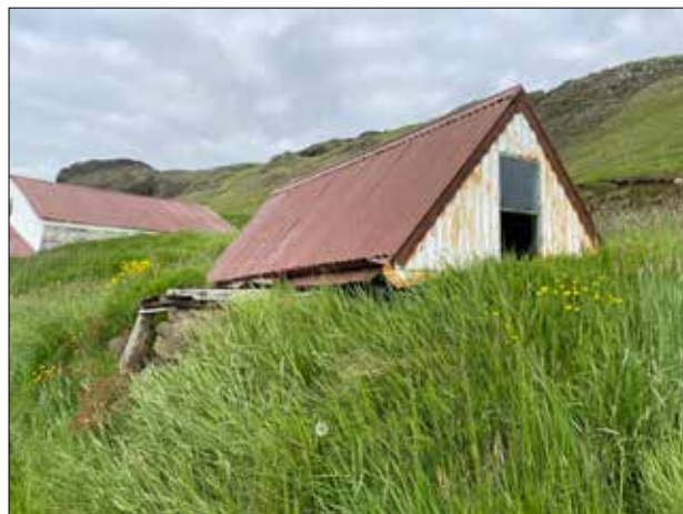
Hús ÁR-233:064, horft til norðausturs.
