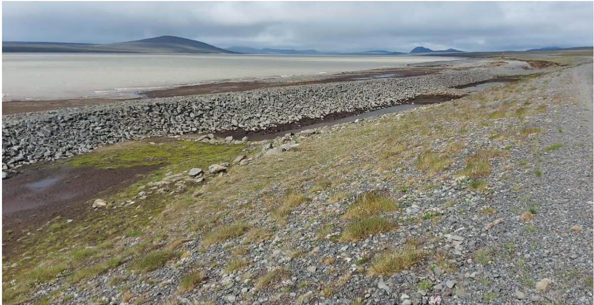
Mynd 18. Nýir grjótgarðar á Kofaöldu sem bæði mynda vörn gegn öldurofi og virka sem sandgildirur. Fokgirðingar sem eru á höftum milli sandgildra eru einnig að ná að fanga áfoksefni og draga þannig úr því magni sem berst yfir veginn og inn á gróið land (mynd 19).
