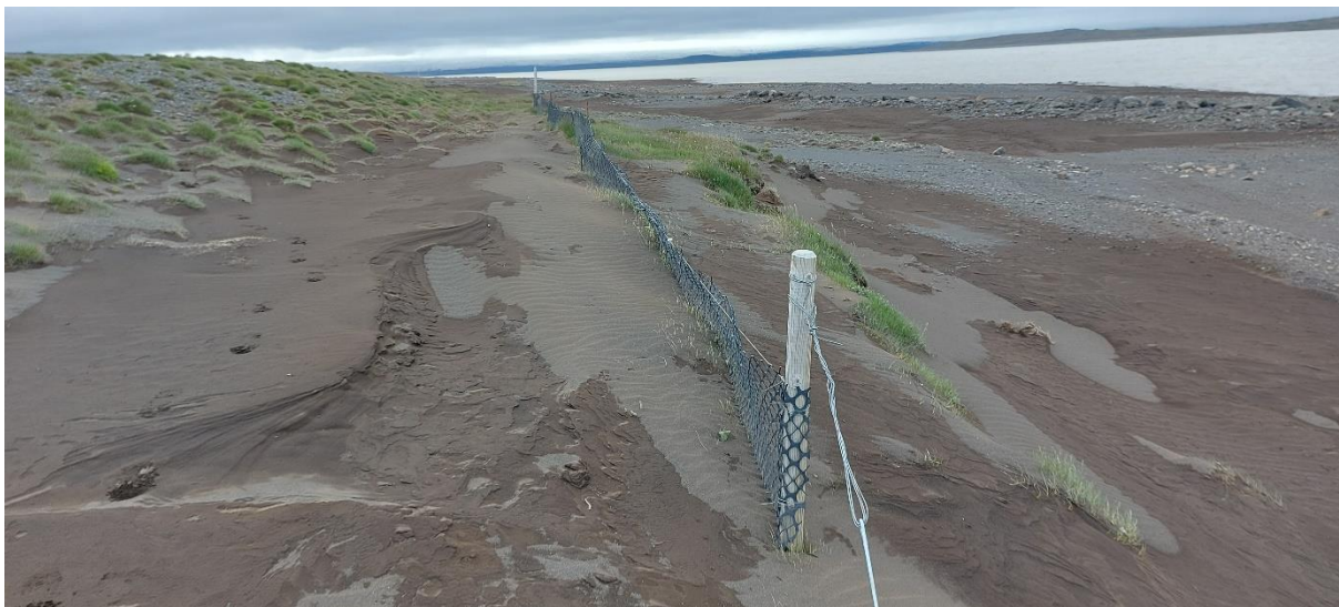
Mynd 19. Fokgirðingar á Kofaöldu 4. júlí 2023 sem safnað hafa í sig talsverðu magni af áfoksefnum. Þessar mótvægisáðgerðir virðast því ná að draga verulega úr þeim skaða sem áfok úr lónstæðinu veldur þegar óhagstæðar veðuraðstæður skapast við Háslón.
