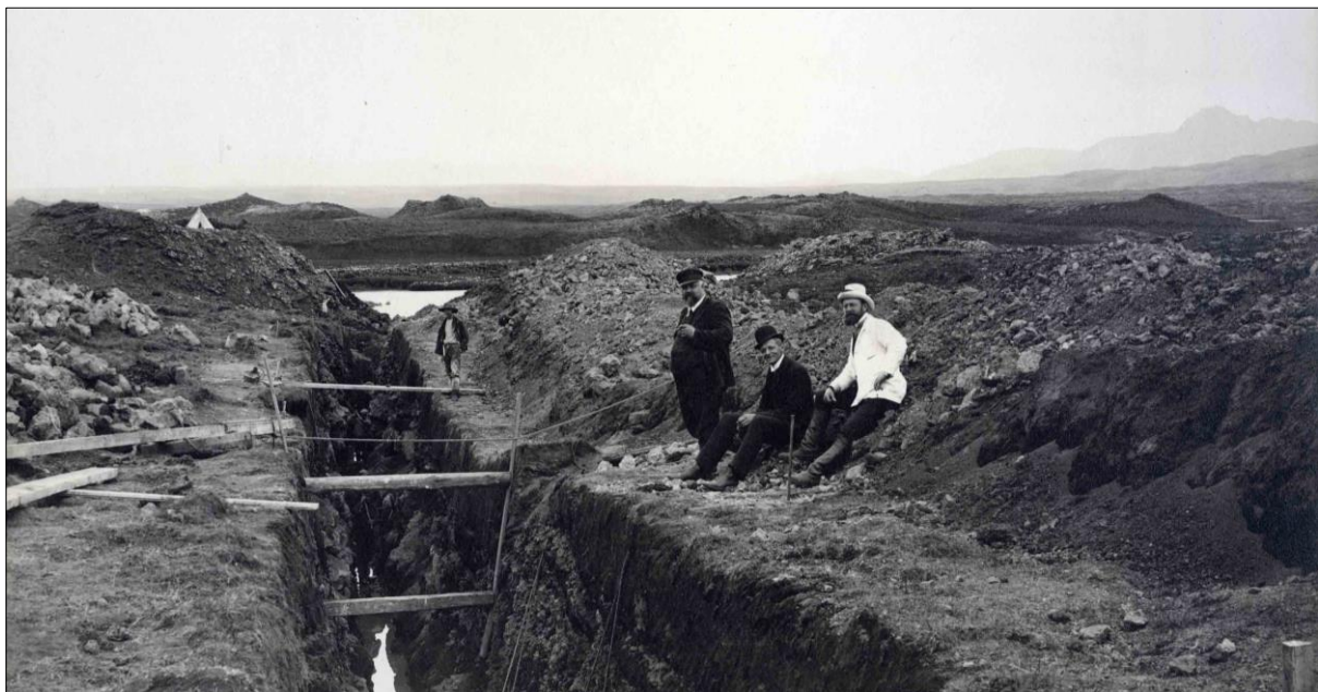
Mynd 4. Ljósmynd tekin í tilefni af vatnsveituframkvæmdum 1908-1909. Yfirverkfræðingur framkvæmdanna, Holgeir A. Hansen, stendur við skurðinn en við hlið hans eru Knud Zimsen þáverandi bæjarverkfræðingur og líklega K.V. Kjögx (hvítklæddur) sem hafði yfirumsjón með greftri lagnaskurðanna. Í baksýn sjást Rauðhólar. 28
