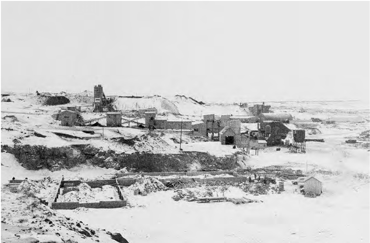
Mynd 18. Horft yfir athafnasvæði Grjótnáms Reykjavíkur (1960-1965). Í forgrunni má sjá grunn að byggingu Pípugerðar Reykjavíkurborgar sem reist var 1965. Fyrir miðri mynd má sjá „nýju grjótmulningsstöðina“ sem samanstendur af fjórum húsum sem tengjast með færíbandi. Í baksýn sést athafnasvæði Steypustöðvarinnar að Malarhöfða. 51
