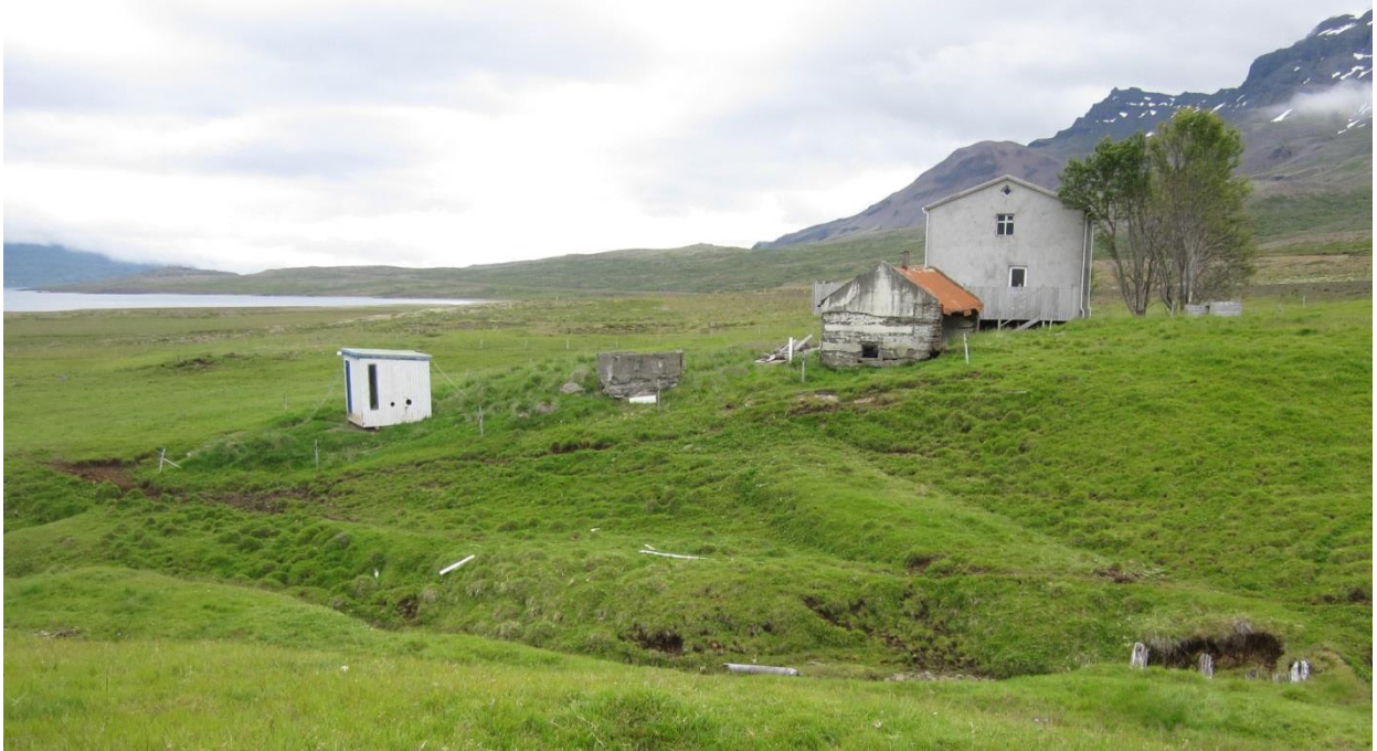
Mynd 2. Horft til suðausturs yfir bæjarhólinn (nr. 1). Vegur sem var upphlaðinn á kafla lá frá bænum í átt til bæjarlækjar og að fjárhúsunum sem voru hinu megin lækjar. Við íbúðarhúsið (1912) eru leifar steinsteypts fjóss (1950) og vinstra megin við það steypdur súrheysturn (mögulega frá því um 1960).
