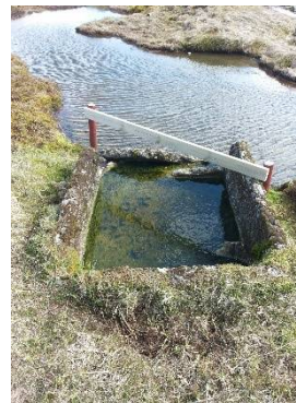
Mynd 3. Horft til norðvesturs yfir steinsteypnan grunn frá hitaveitunni á Reykjum.
