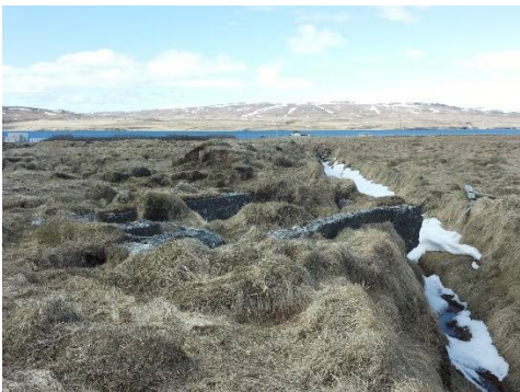
Mynd 1. Horft til vesturs eftir framræsluskurði sem grafinn hefur verið við steyptan sökkul fyrir hitaveituna.
