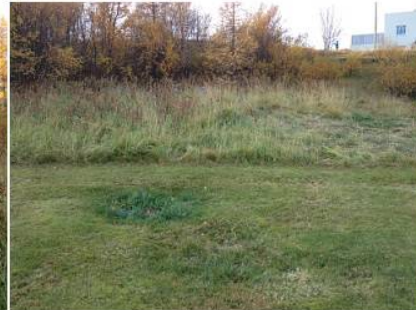
IMG_0341 Dæld (1786-14) austan við steypa grunninn vestan við Skarðshlíð 23-27.
