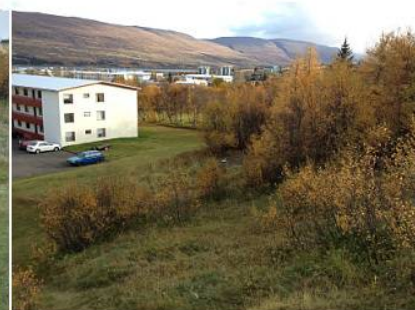
IMG_0342 Horft til suðausturs að vesturenda fjölbýlishússins Skarðshlíðar 23-27, steypur grunnur sést fyrir miðri mynd. En þurrabúðarbýlið Garðshorn (1786-11) var einhverstaðar vestan við húsið.
