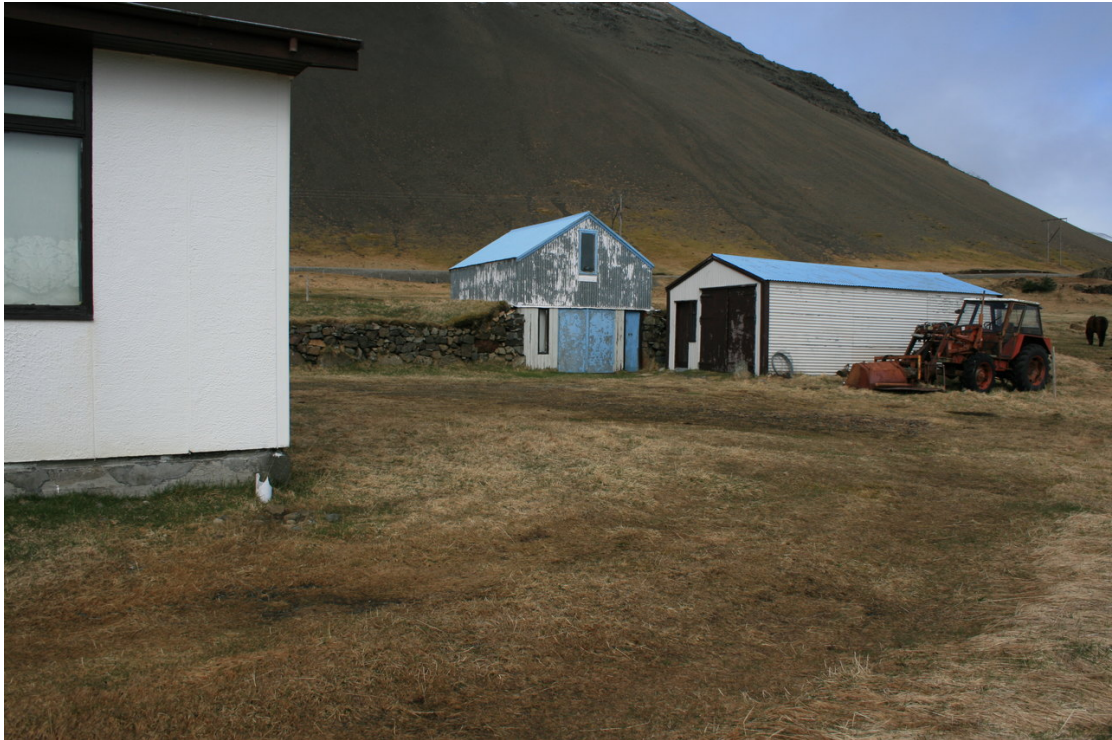
Mynd 3. Núverandi íbúðarhús og skemma í Svínhólum, horft til norðausturs. Ljósm. SGB, apríl 2017.
