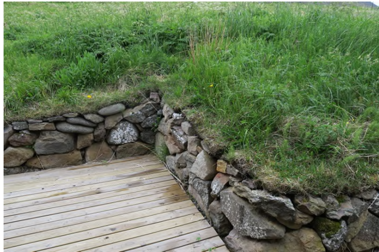
Mynd 12. Hluti af hleðslunum sem voru endurnýjaðar þegar grafið var niður á fjánhús við framkvæmdir vegna byggingar sumarbústaðar. Þessi veggur er vestan við sumarbústaðinn.
