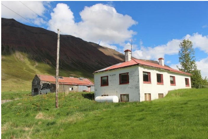
Mynd 7. Íbúðarhús á Brúarlandi. Rafstrengurinn mun liggja að húsinu þar sem olíutankur liggur. Þar hafa fundist mannvistarleifar frá elstu byggð.
