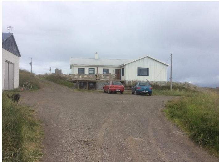
Mynd 2. Horft til austurs yfir bæjarstæðið á Krossi. Gamli bærinn stóð á sama stað og bílastæði og steipt útihús nær á myndinni.
