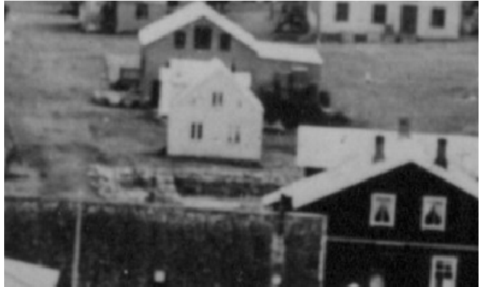
Mynd 14 Sauðárkrókur í kring um 1905. Steinhleðslan fyrir miðri mynd er líklega grunnur Péturshöndlunar sem brann 1902 og húsið Uppsalar voru síðan byggðir á 1904. Ljós. HSK.
