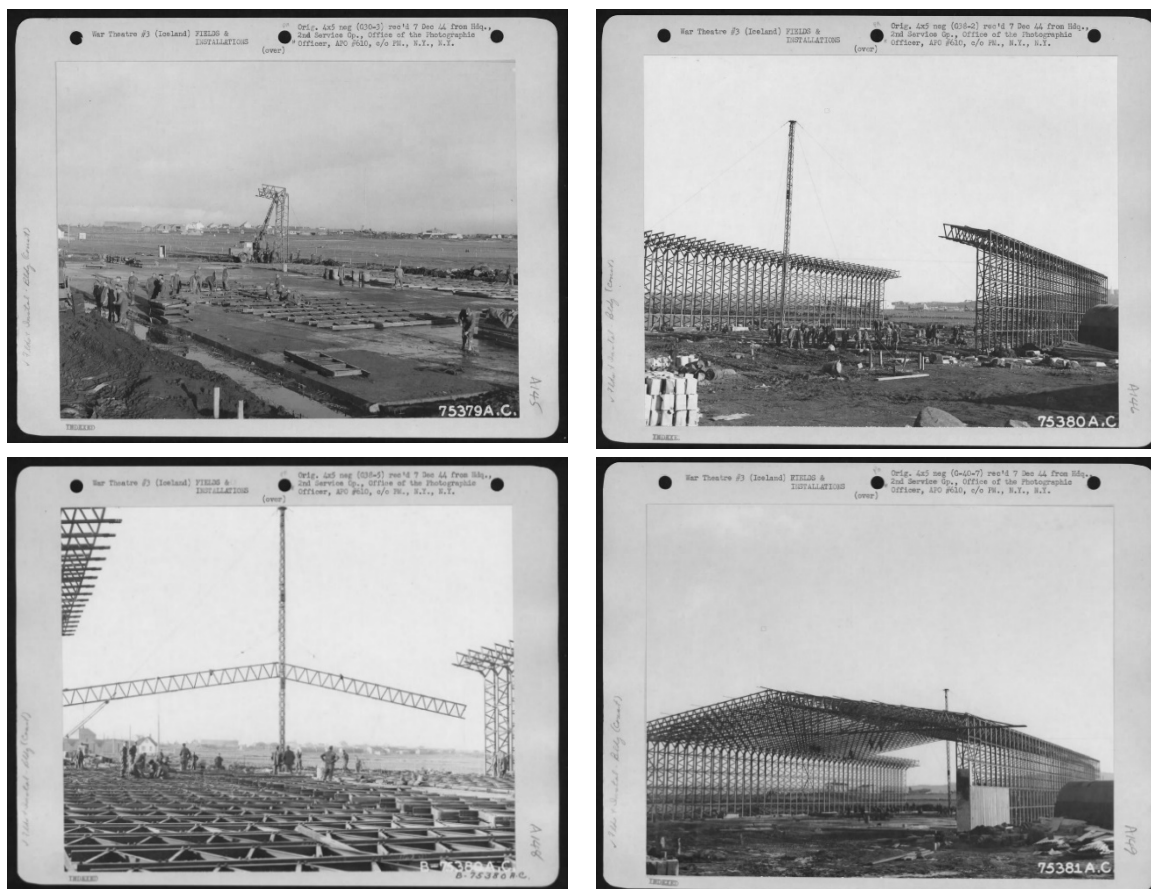
Mynd 41 Myndir frá því í október 1941 þegar flugskýli nr. 5 var reist, en flugskýli nr. 3 er af sömu gerð. 140
