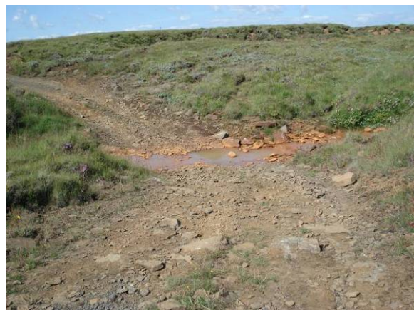
Flóðalækjarvað RA-408:040, horft til norðurs
