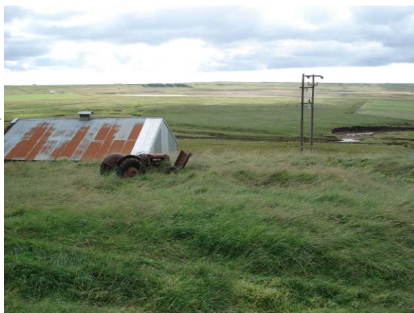
Tóft um 7 m V við þúst 013, horft til S
