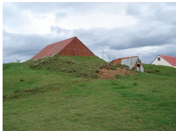
Yfirbyggingar yfir Berustaðahelli, horft í NA
